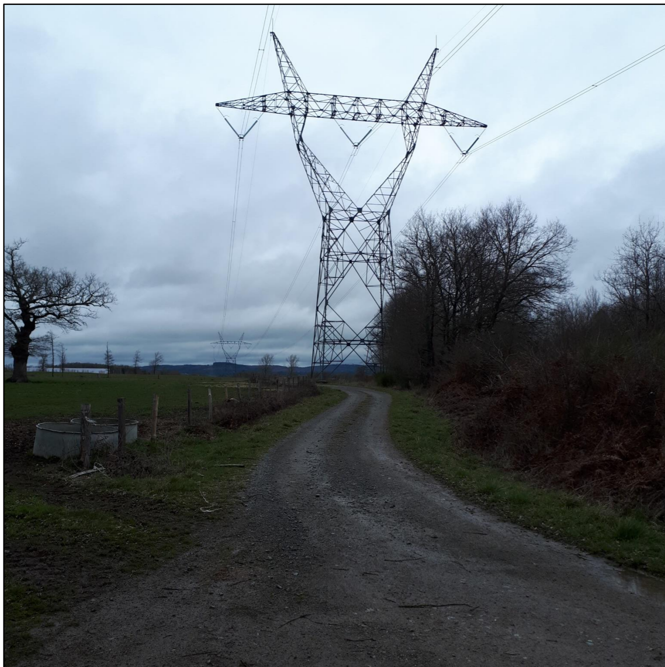
Illustration 141 : Vue sur le pylône n°224 et la ligne électrique depuis le sud-est de la zone du projet (Source : EREA Ingénierie – mars 2019)
