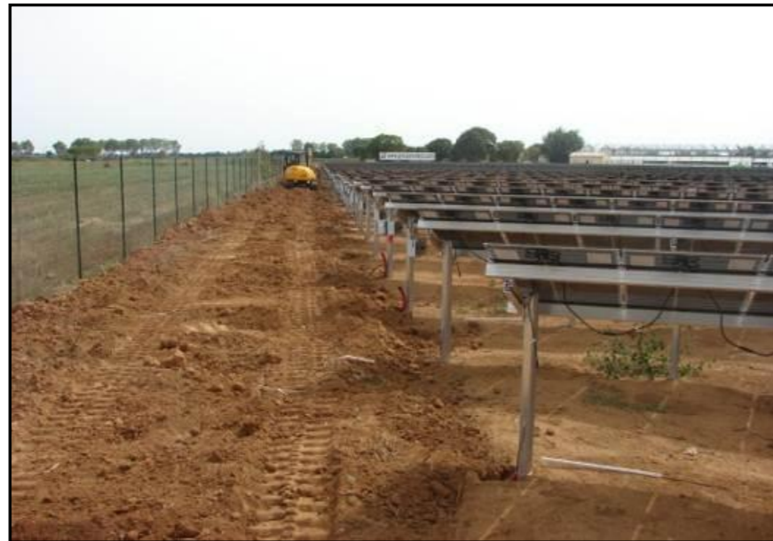
Illustration 192 : Récouvrement des tranchées
