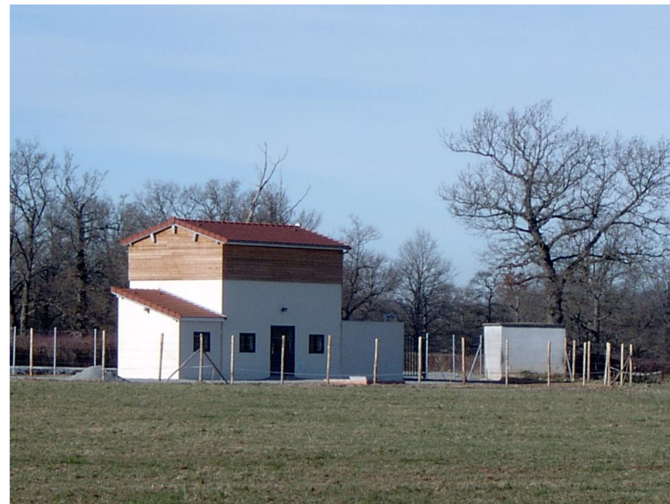
Illustration 143 : Station de traitement de Lussat (source : siaep-gouzon.fr)
