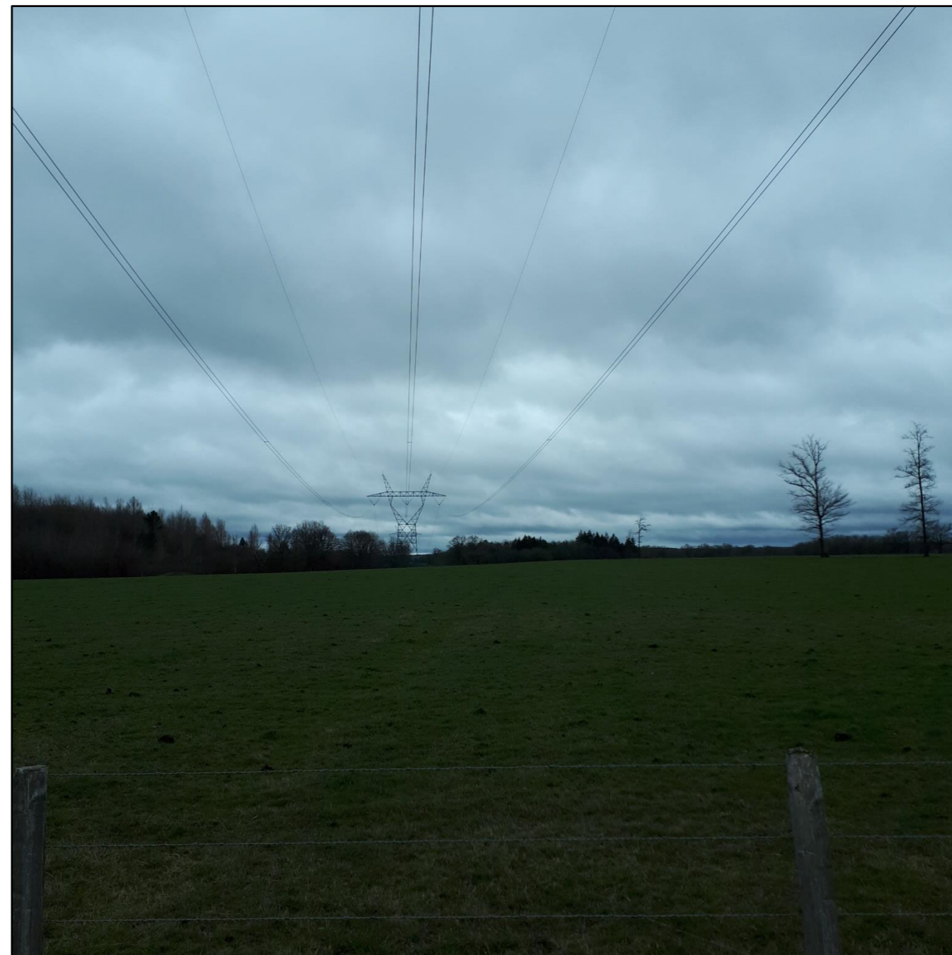
Illustration 142 : Vue sur le pylône n°224 et la ligne électrique depuis le nord du site (Source : EREA Ingénierie – mars 2019)
